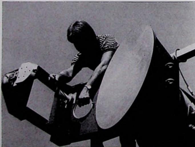
**Bild 1: Einbau eines Ringrillenerregers in die Kopernikus-Antenne**
